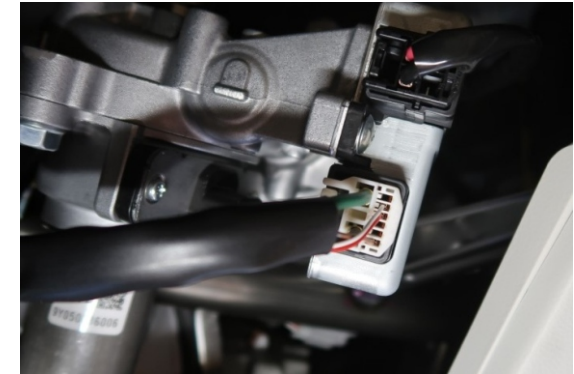
Stecker am Servolenkungs-Steuergerät an der Lenksäule.
